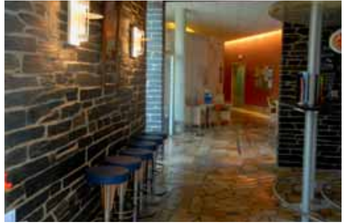
Wandbekleidung aus Schiefer, kombiniert mit Quarzit
